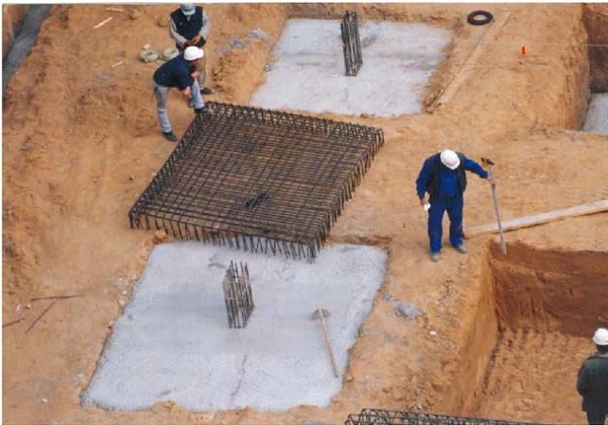
Cuando, por el contrario, el terreno presenta poca cohesión se hace preciso realizar excavaciones más amplias y emplear un encofrado convencional.
