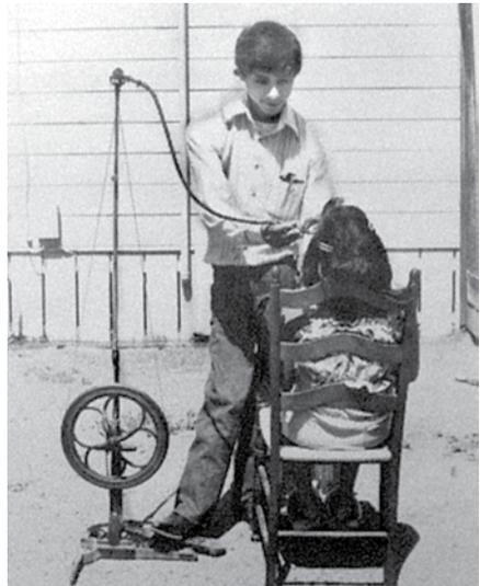
Aquí se puede ver trabajadores dentales de una localidad del oeste de México, usando una bicicleta en la que pedaleando rápidamente puede proporcionar aire a la compresora para accionar el taladro de alta velocidad.
