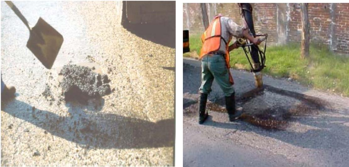
**Figura 2.2** Técnicas de Reparación de Baches.
